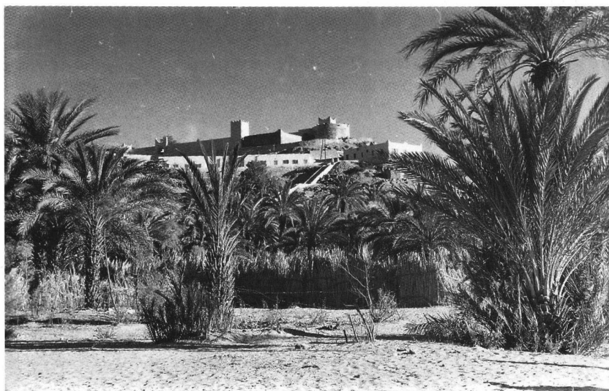
Le fort de Djanet (Photo P. de Galbert)
